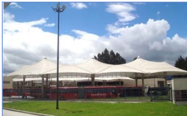
Figura 3-11. Patios de operación, mantenimiento y estacionamiento de TransMilenio.
