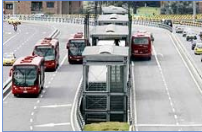
Figura 3-8. Estaciones sencillas TransMilenio
