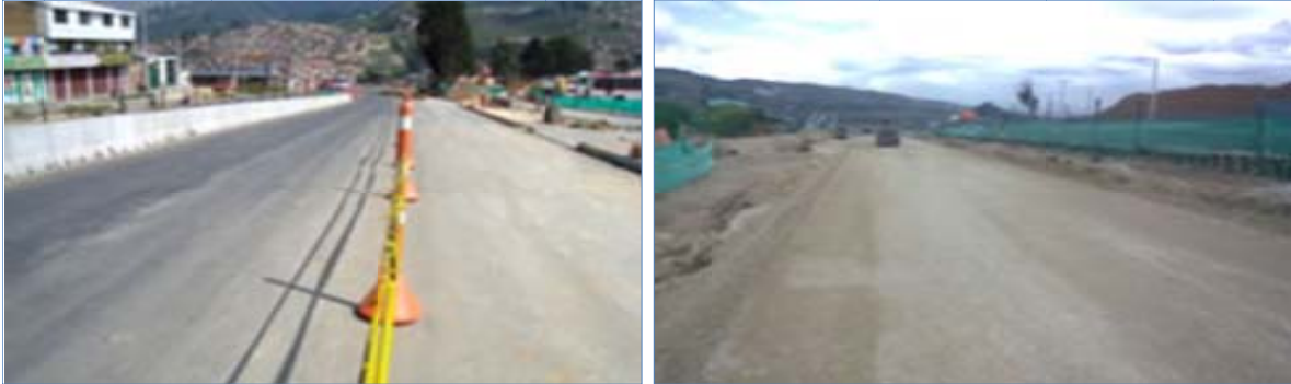
Figura 3-13. Avance de las obras de la Autopista al Llano
