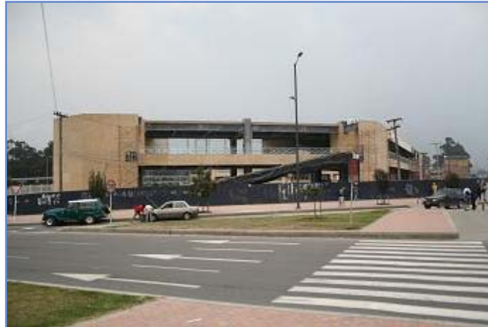
Figura 3-25. Construcción de Terminal Sur.
