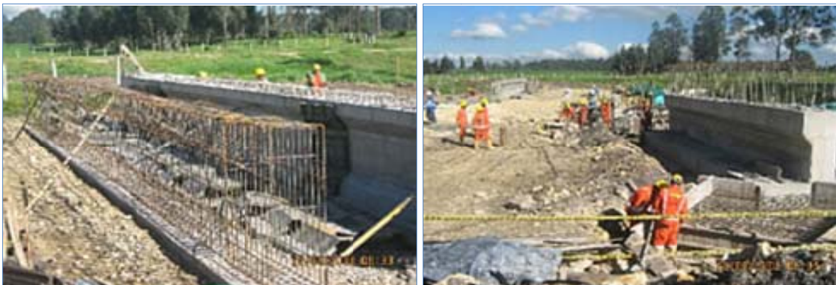
Figura 3-12. Avance de las obras de la Avenida Longitudinal de Occidente
