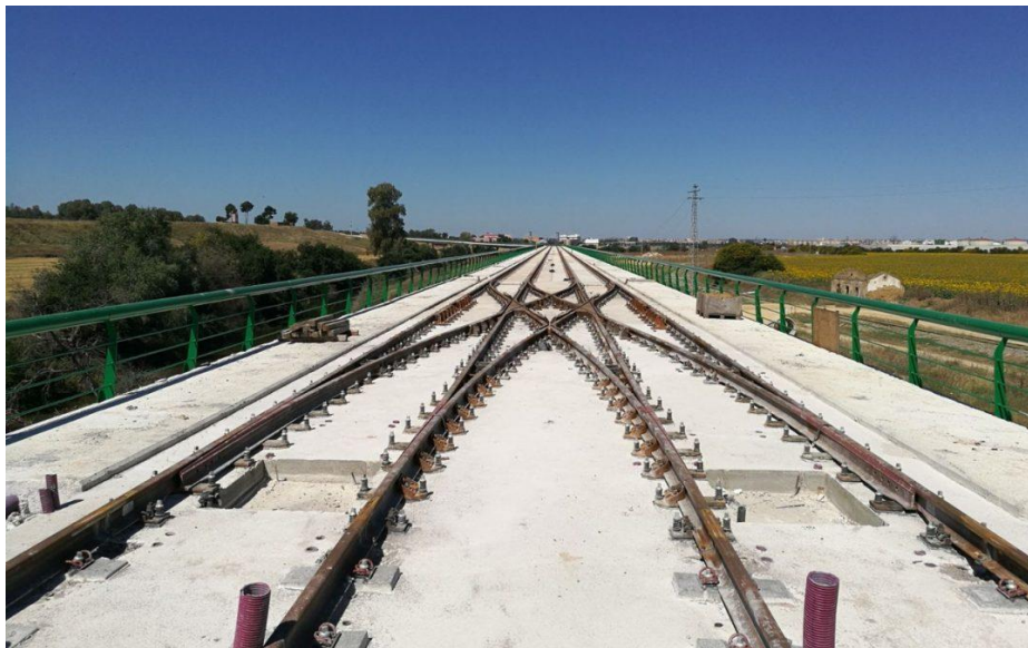
Figura 66 Cruzamiento Doble o Bretelle
