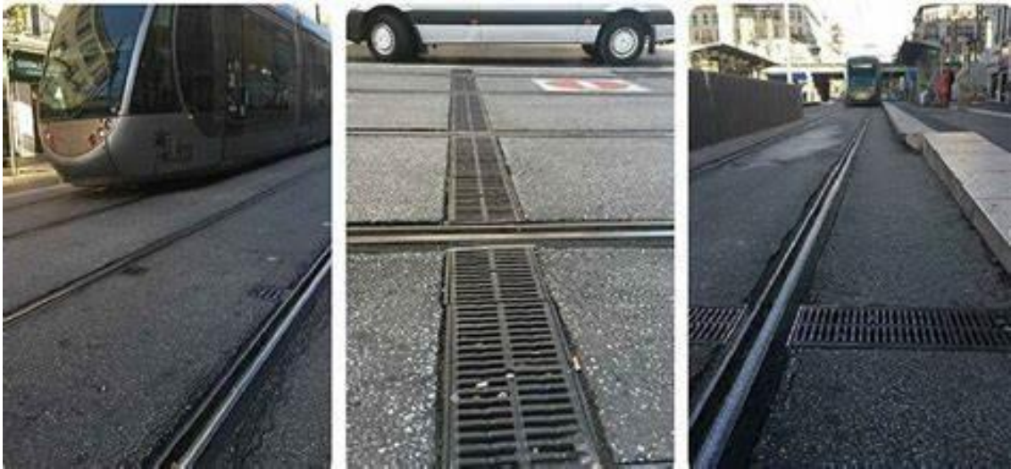
Figura 13 Vía en Placa con Riel Embebido.
