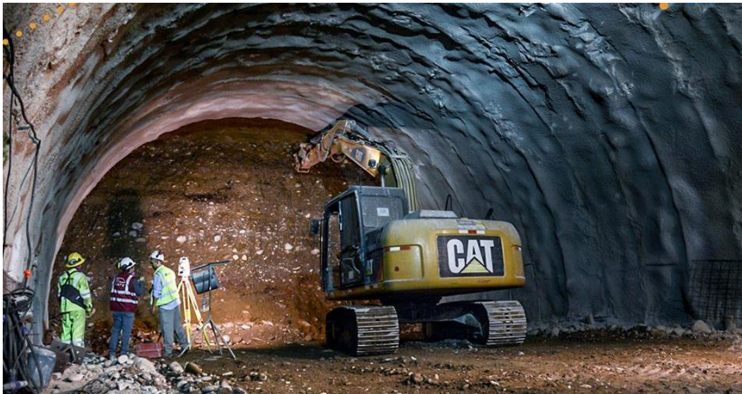
Figura 3 Método de Excavación y soporte NATM
