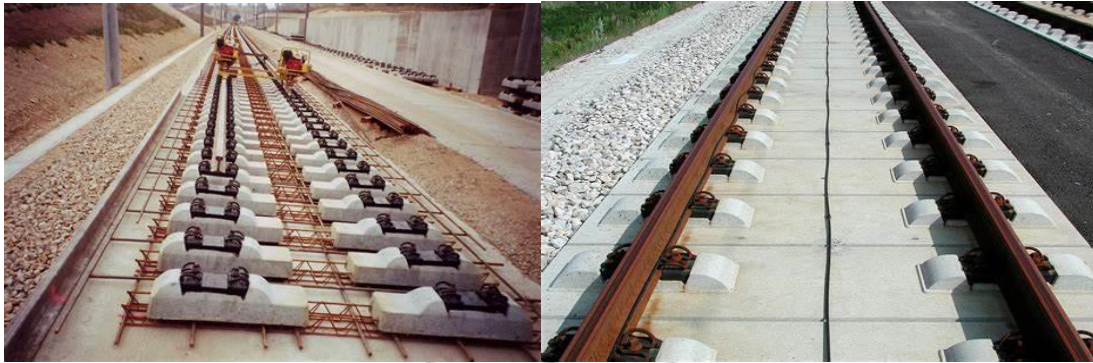
Figura 11 Vía en Placa con Traviesas Embebidas.
