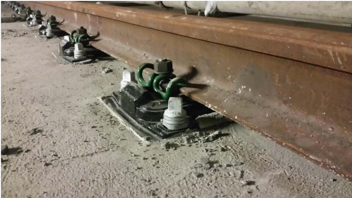
Figura 12 Vía en Placa con Sujeción Directa.
