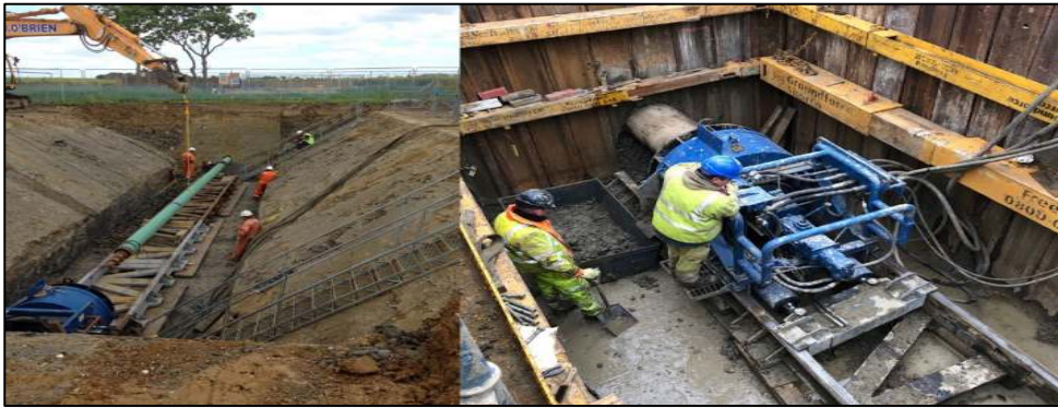
Ilustración 2.1-17 Entubado de cámara de lanzamiento
