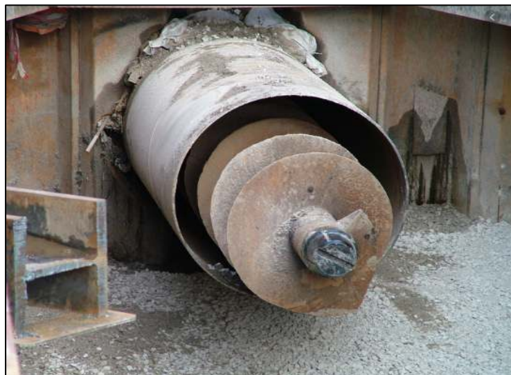
Ilustración 2.1-19 Cámara de salida
