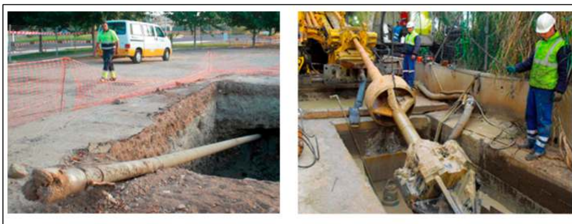
Ilustración 2.6-19.1. Fases de la instalación de la tubería.
