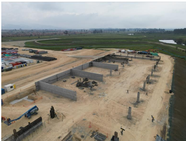
Así se ve la construcción de la zona de acopio de materiales del patio de prefabricados de los pilotes PC
