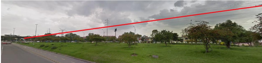
Figura 14. Puente de la Av. 68 con la Tv. 53, donde la red de AT pasa por encima y luego paralelamente a la vía férrea.
