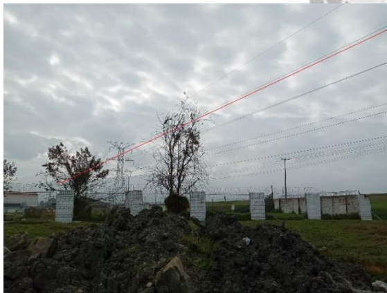
Figura 4. Inicio del recorrido redes eléctricas de AT.
