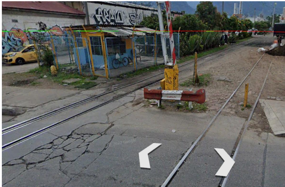
Ilustración 55 Identificación de rieles (Intersección Carrera 22 X Diagonal 19A) hacia el Sur
