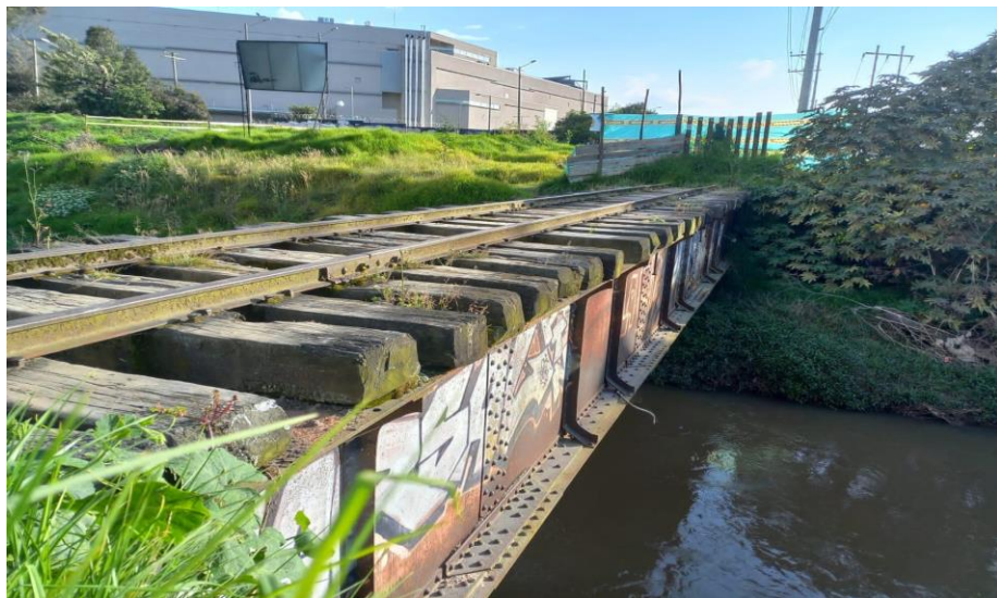
Ilustración 49 Identificación de rieles Puente férreo (Intersección Avenida ferrocarril de Sur X Intercepción Rio Tunjuelo)
