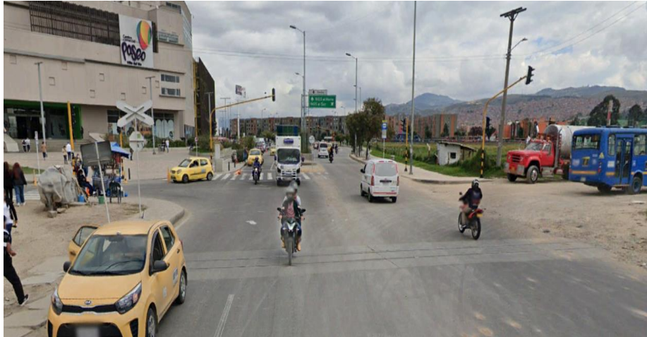
Ilustración 50 Identificación de rieles Puente férreo (Intersección Avenida ferrocarril de Sur X Carrera 63)
