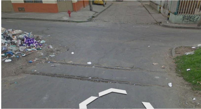
Ilustración 47 Identificación de rieles (Intersección Avenida ferrocarril de Sur X Calle 39DSur)
