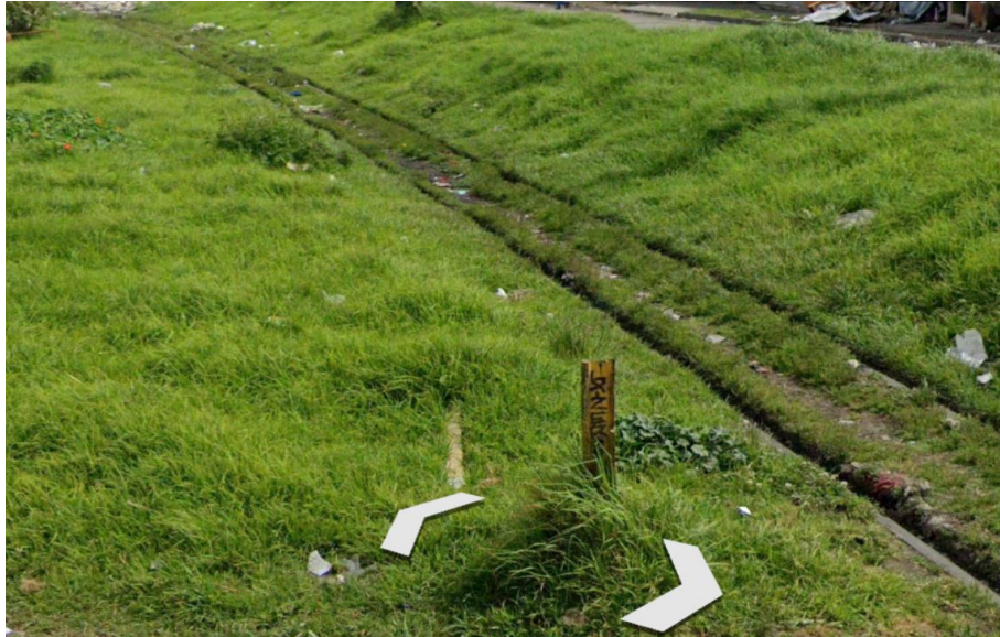
Ilustración 54 Identificación de rieles (tramo zona verde) hacia el norte en dirección a Carrera 19 B
