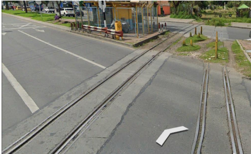
Ilustración 52 Identificación de rieles (Intersección Calle 19 X Diagonal 19 A) hacia el Sur
