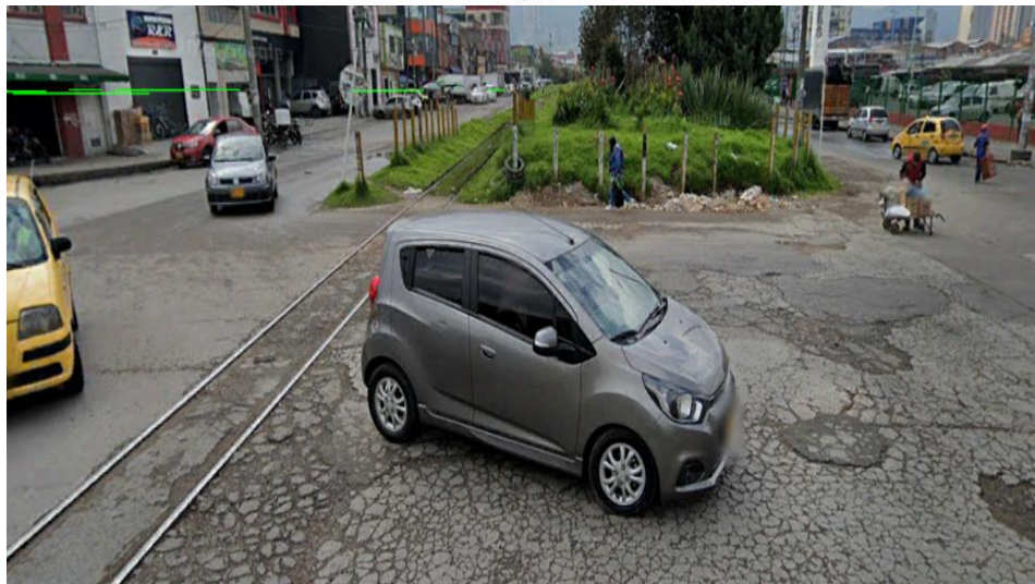
Ilustración 57 Identificación de rieles (Intersección Carrera 27 X Calle 22) hacia el Sur
