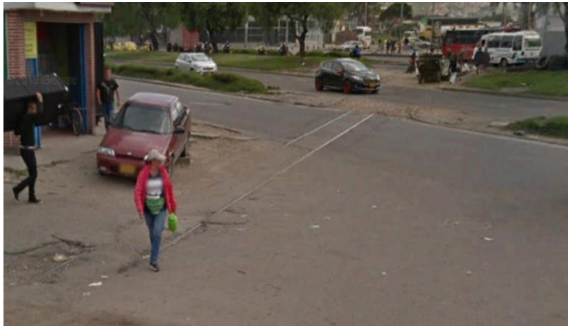
Ilustración 48 Identificación de rieles (Intersección Avenida ferrocarril de Sur X Avenida Boyacá)
