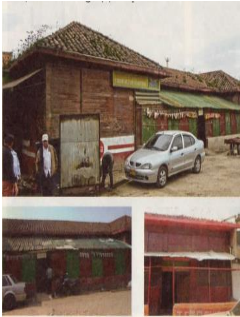
Ilustración 28 Estación de Soacha (Rojas Carrillo, 2020)
