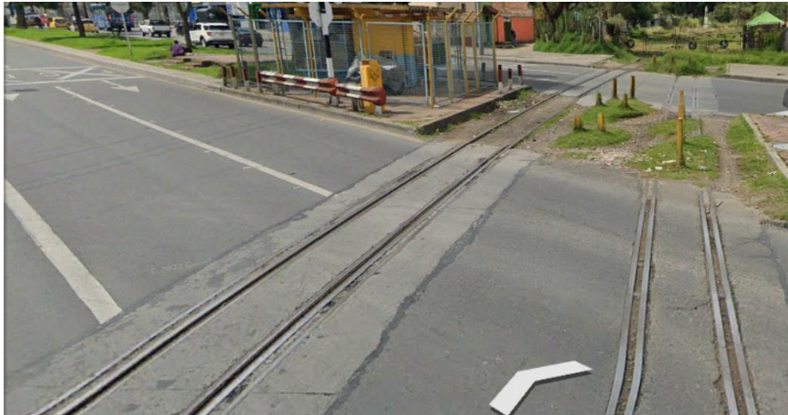
Ilustración 38 Identificación de rieles (Intersección Calle 19 X Diagonal 19 A) hacia el Sur
