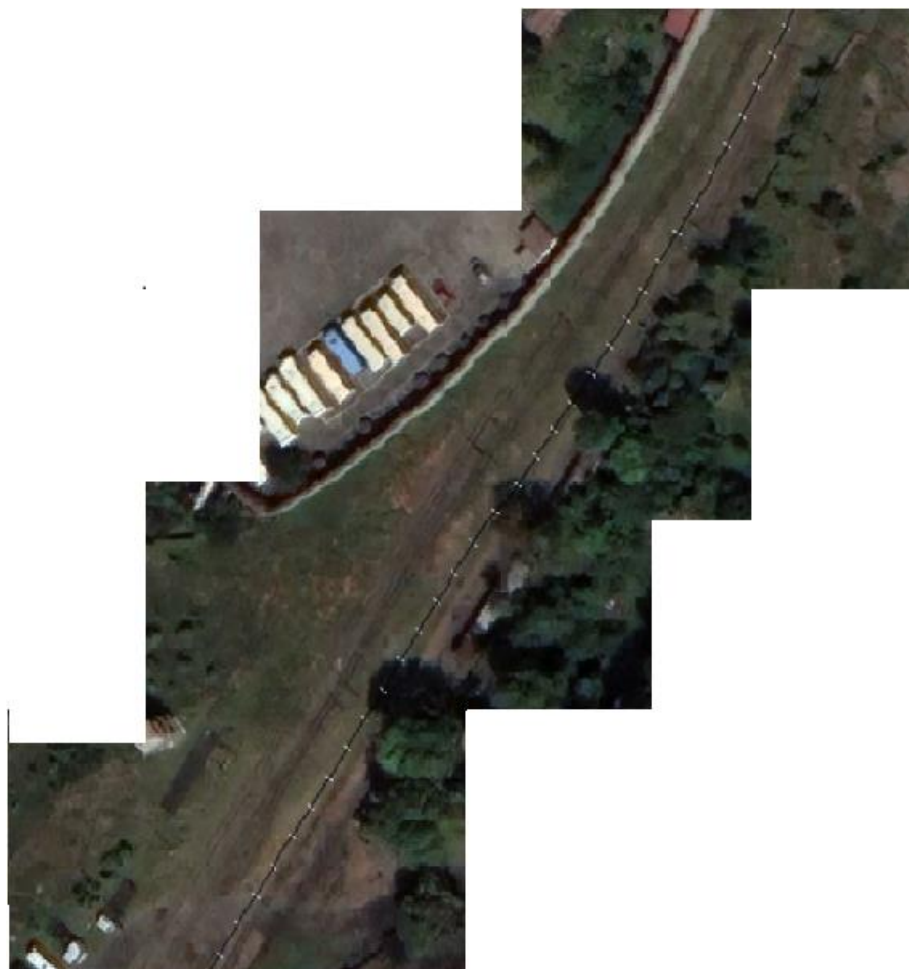
Ilustración 37 Identificación de rieles (tramo zona verde) hacia la estación de la Sabana
