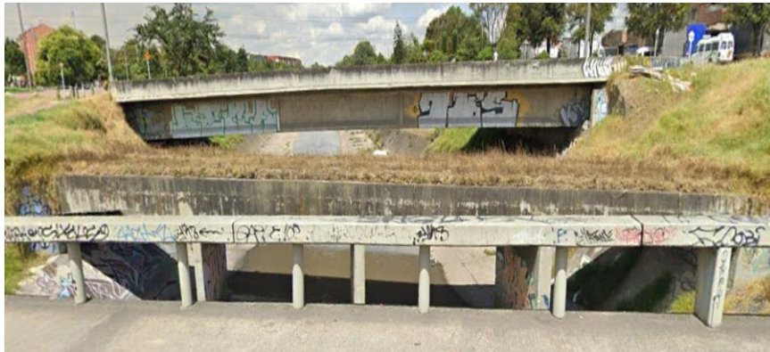
Ilustración 45 Identificación de rieles Puente férreo (Intersección Avenida ferrocarril de Sur X Diagonal 16 Sur)
