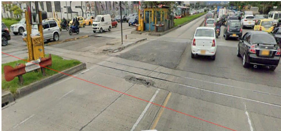
Ilustración 59 Identificación de rieles (Intersección Carrera 30 ó NQS X Calle 22)
