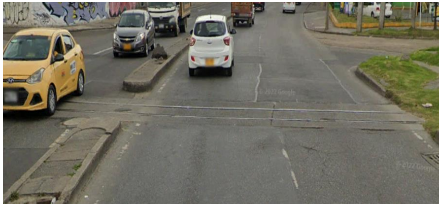
Ilustración 42 Identificación de rieles (Intersección Calle 19 X Carrera 39)
