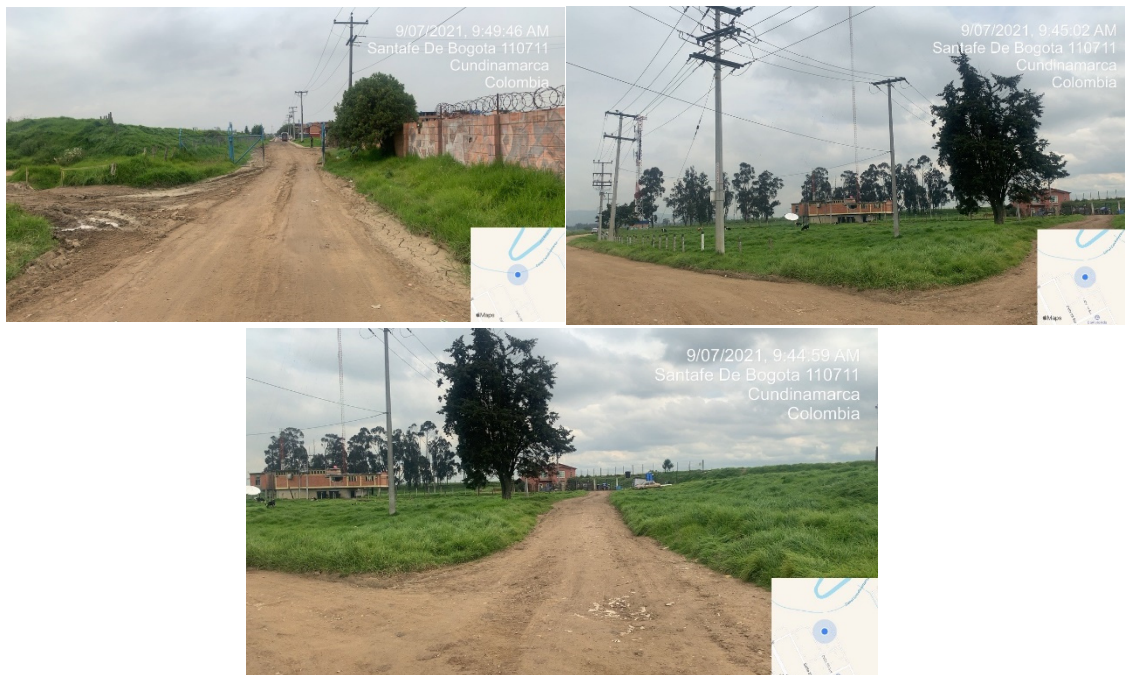
Figura 2. Estado vía de acceso - Patio Taller
