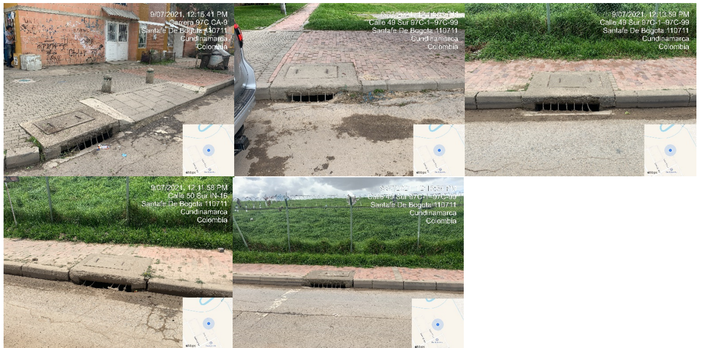
Figura 12. Sumideros cercanos a la entrada
