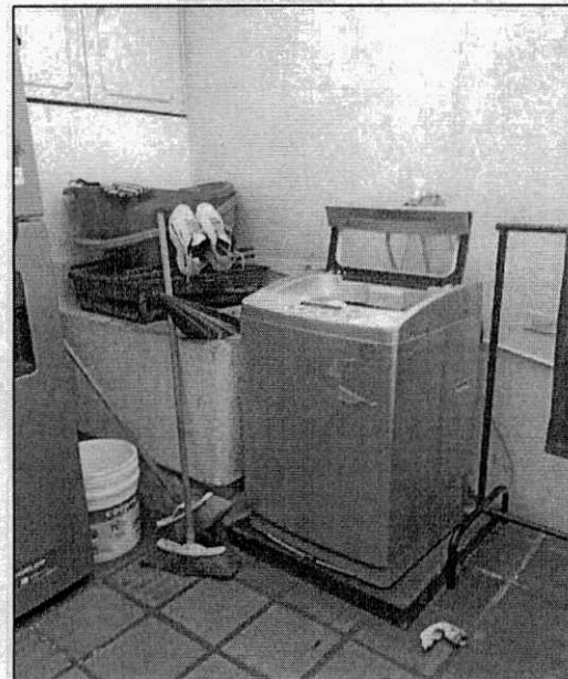
C1 CUARTO PISO LAVADERO
