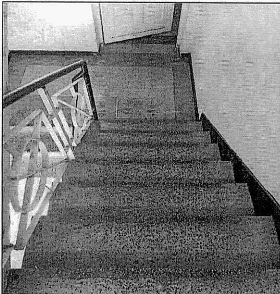
C1 SEGUNDO PISO ESCALERAS
