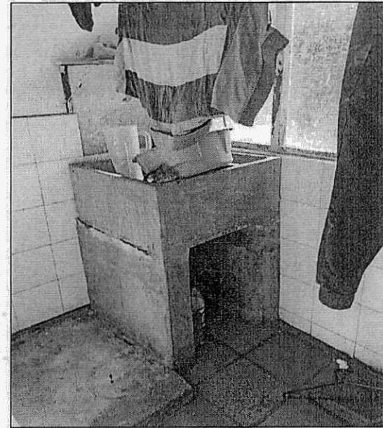
C1 SEGUNDO PISO LAVADERO
