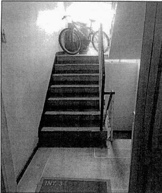
C1 TERCER PISO ESCALERAS
