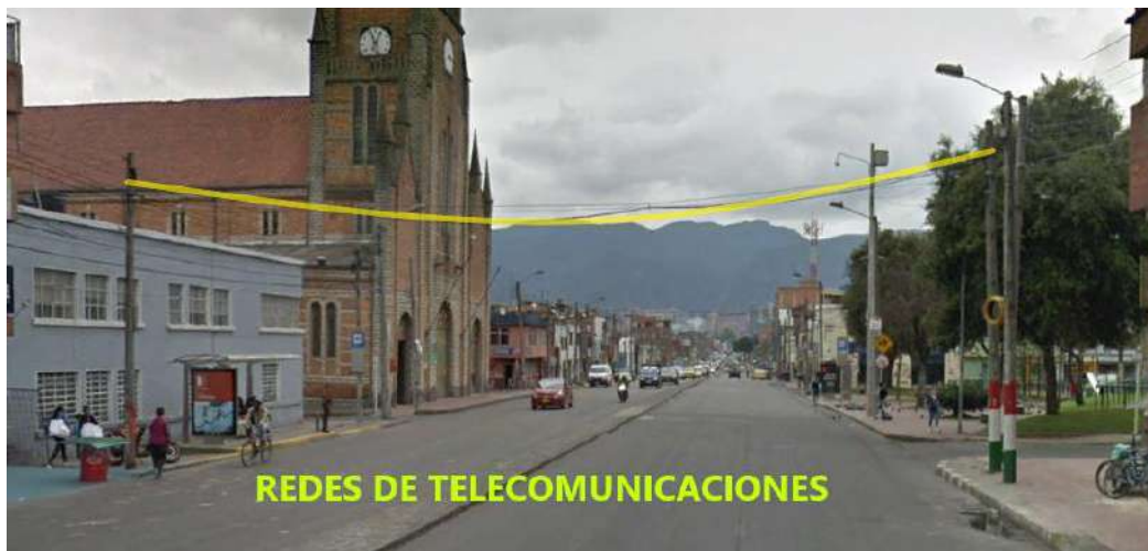
Figura 5.7 Red de Telecomunicaciones Calle 72 – Cra. 57B
