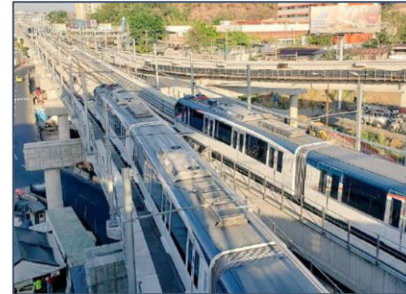
Anclaje en viaducto con postes laterales
