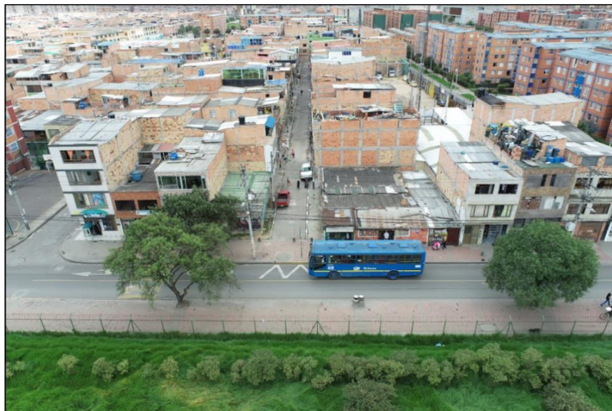
Fotografía 4 Contraste del proceso constructivo sobre la calle 59 sur
