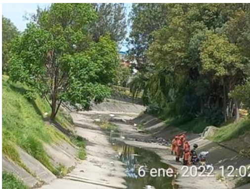
Fotografía 42 Limpieza del canal Río Seco- Tramo 3
