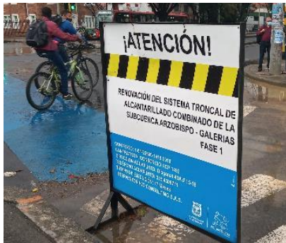
Fotografía 44 Renovación del sistema de alcantarillado - Tramo 4
