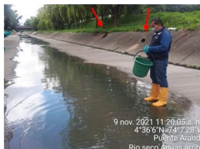
Fotografía 53 Vertimiento con trazas de hidrocarburos y conexiones erradas en Canal Río Seco
