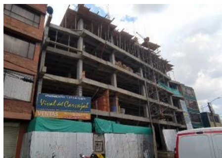
Fotografía 37 Construcción de viviendas– Tramo 1
