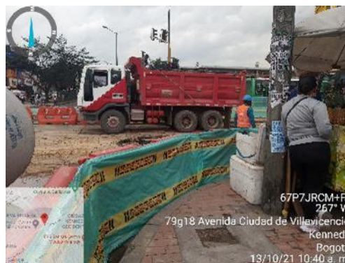
Fotografía 41 Mantenimiento de vía – Tramo 2
