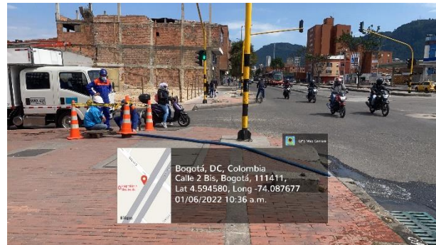
Fotografía 45 Mantenimiento en redes – Tramo 4
