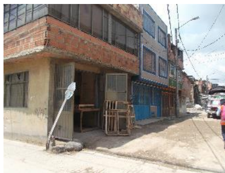
Fotografía 12 Fabricación de muebles– Tramo 4
