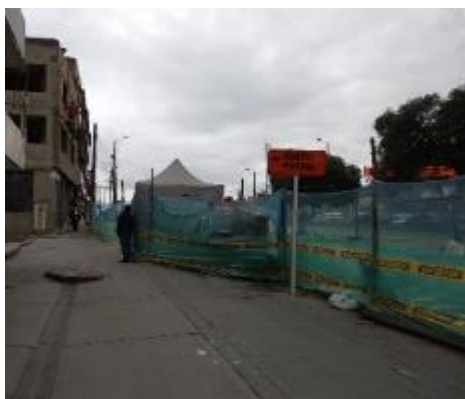
Fotografía 40 Mantenimiento de vía- Tramo 1
