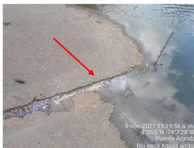
Fotografía 53 Vertimiento con trazas de hidrocarburos y conexiones erradas en Canal Río Seco
