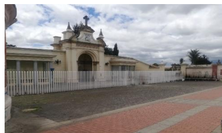
Fotografía 31 Cementerio Central de Bogotá – Tramo 5
