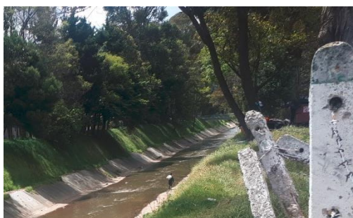
Fotografía 55 Presencia de habitantes de calle en el Canal Río Fucha
