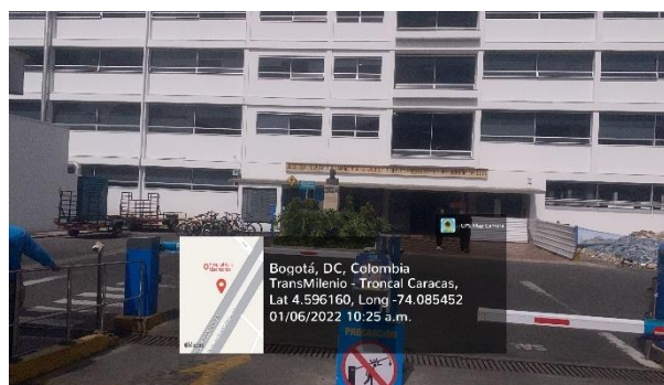
Fotografía 27 Fundación Hospital De La Misericordia – Tramo 4
