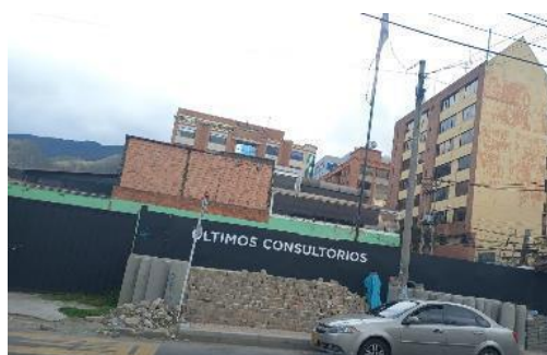
Fotografía 39 Construcción de consultorios – Tramo 6
