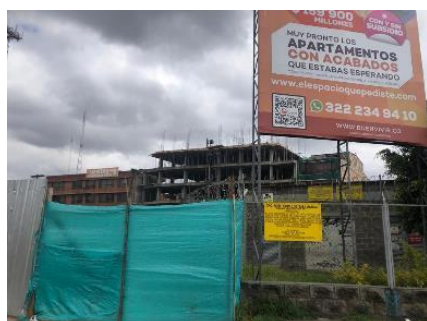
Fotografía 38 Construcción de vivienda – Tramo 2
