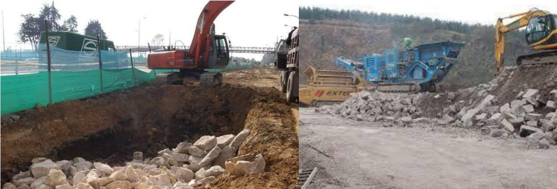
Ilustración 3.5.5-24. Empleo de material de demolición para el mejoramiento de subrasante
