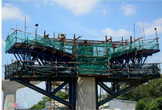
Ilustración 3.5.5-3. Construcción de capitel in-situ. Fuente: SYSTRA
