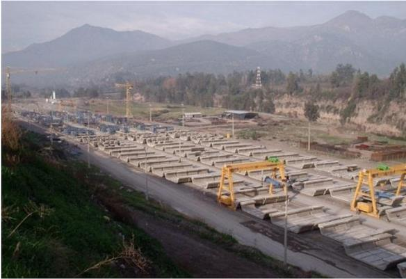
Ilustración 3.5.5-10. Zona de acopio en parque de prefabricación (línea 4 metro Santiago de Chile)
