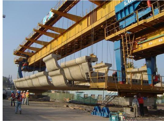
Ilustración 3.5.5-5. Izado de dovelas mediante viga lanzadora (metro de Delhi)
