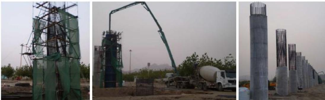
Ilustración 3.5.5-2. Construcción in-situ de elementos de subestructura. Fuente: SYSTRA
