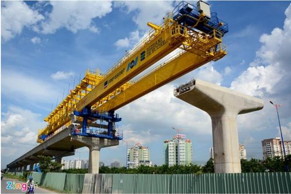
Ilustración 3.5.5-4. Viga lanzadora para viaducto en "U" del metro de Ho Chi Minh
