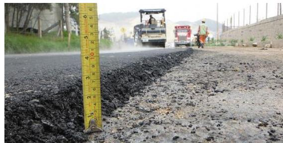
Ilustración 3.5.5-26. Construcción de capa de rodadura con la utilización de material reciclado de llantas
