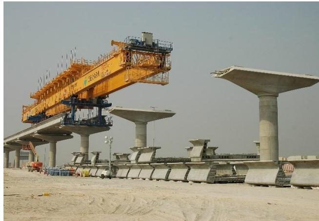
Ilustración 3.5.5-13. Ubicación de dovelas con viga lanzadora. Acopio de dovelas en obra previo a montaje con viga lanzadora
