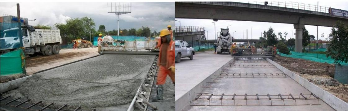
Ilustración 3.5.5-25. Construcción concreto neumático carril BRT
