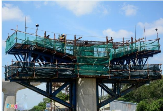
Fotografía 7.7 Construcción de capitel in situ
